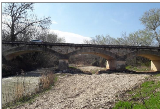
Pont de la RD 98
