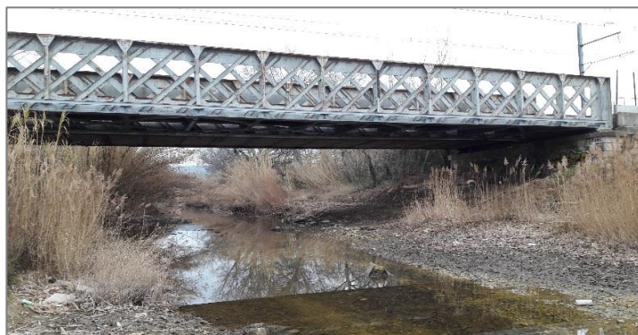
Pont de la voie ferrée
