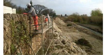
Comblement des cavités en béton de remplissage dans la zone d'enrochement et déjointement / rejointoiment du mur côté Coulon
