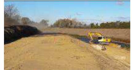
Réalisation de la protection en blocs d'enrochement du pied de digue côté Coulon
