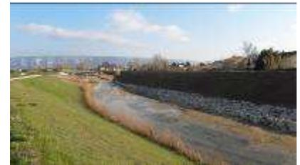
Purge et préparation de la partie supérieure de la digue (corps de digue homogène et en bon état préservé).
