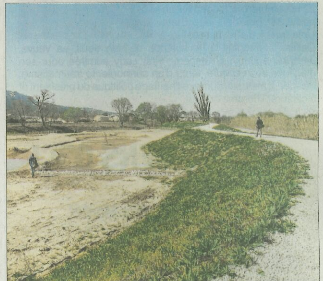
Entre le lit de la rivière et le pied de la digue, un espace compensation environnemental, qui préserve la faune et la flore, a été créé.
