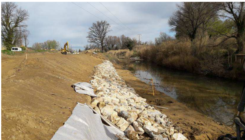
Réalisation de la protection en enrochement en pied de digue en aval du pont RD 938 et raccordement aux enrochements du bras de délestage de la Canaou
