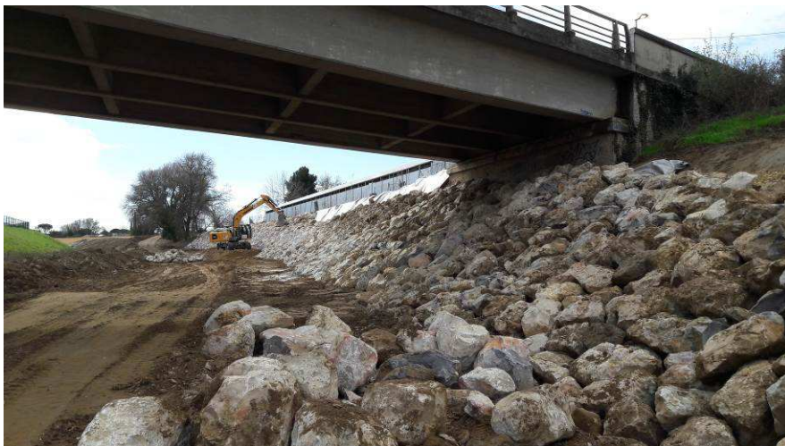
Réalisation de la protection en enrochement au droit de l'entrepôt VIAL et sous le pont de la RD 938
