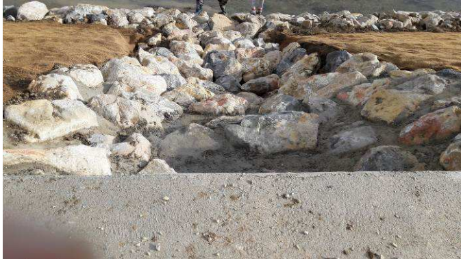
Percolation des enrochements de la descente d'eau
