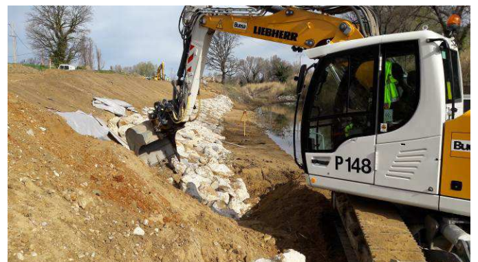
Réalisation de la protection en enrochement en pied de digue en aval du pont RD 938 et raccordement aux enrochements du bras de délestage de la Canaou
