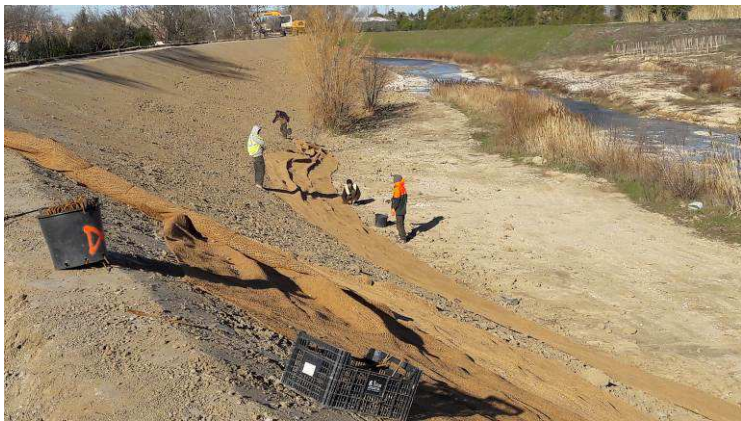
Mise en place de la jute de fibre de coco (protection des talus) + ensemencement.
