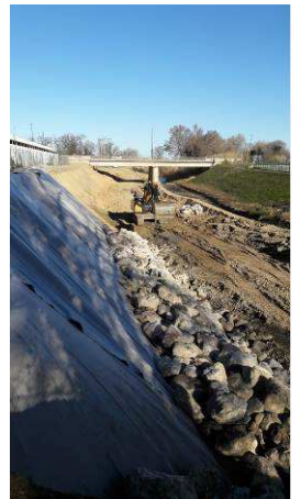
Mise en place de la jute de fibre de coco (protection des talus) + ensemencement.
