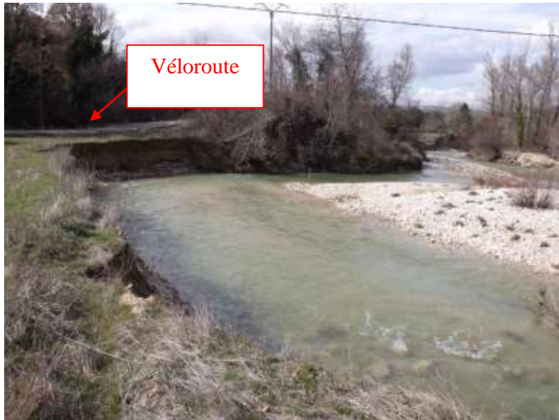
Figure 3 : anse d'érosion des Plaines (vue vers l'aval)
