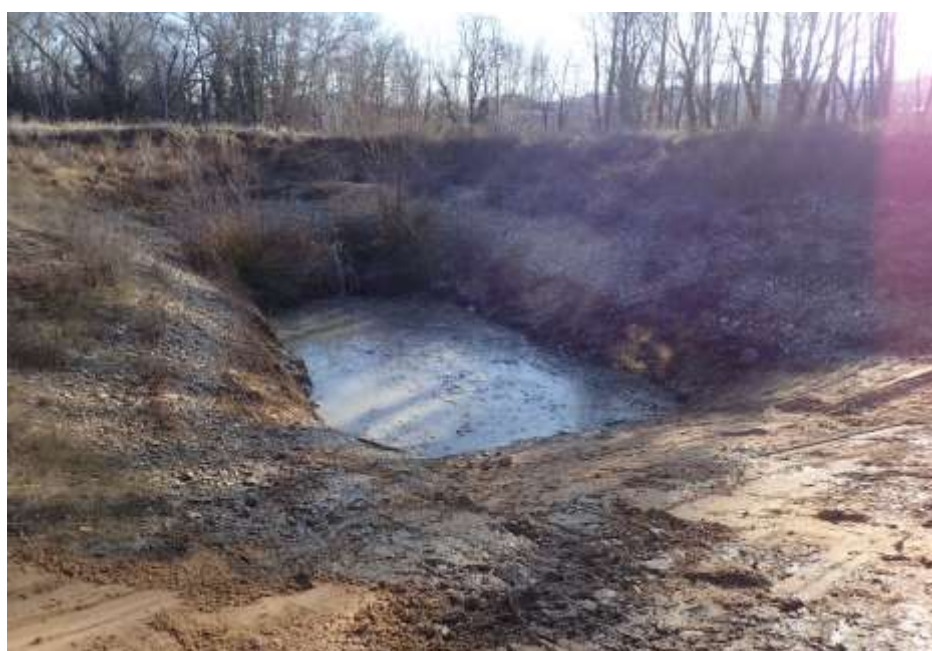
Marre à l'issue des travaux de curage
