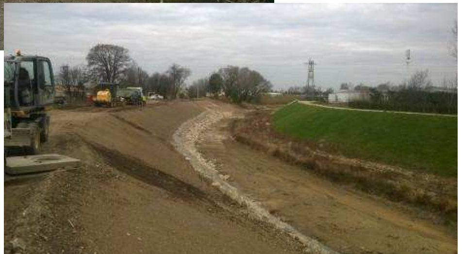
Réalisation des ouvrages traversant au droit du bassin des Ratacans
