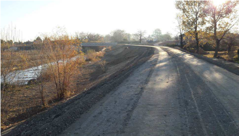
Mise en œuvre des remblais argileux en crête de digue entre l'ouvrage SNCF et le bassin des Ratacans.
