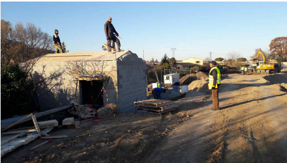
Réalisation du local technique du poste de refoulement au droit du bassin pluvial des Ratacans
