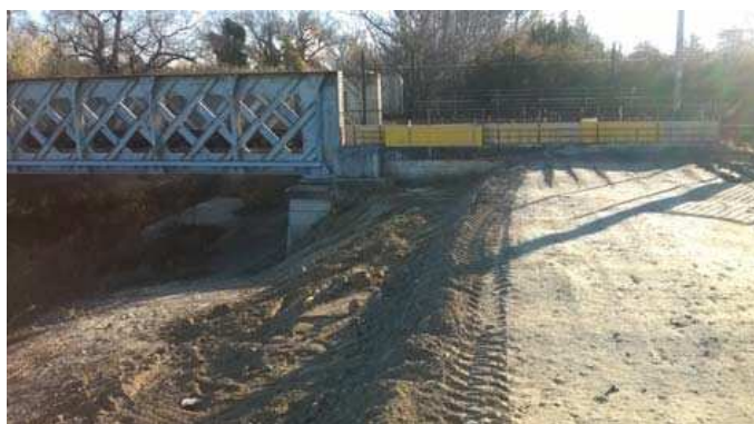
Réalisation d'une longrine béton sur l'arase de couronnement de l'ouvrage SNCF.
