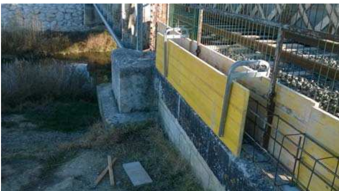
Réalisation d'une longrine béton sur l'arase de couronnement de l'ouvrage SNCF.
