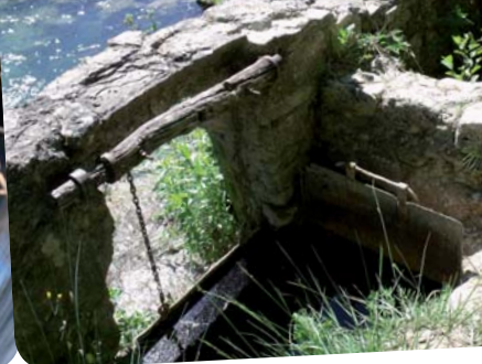
Seuil de Châteaupert à Viens
