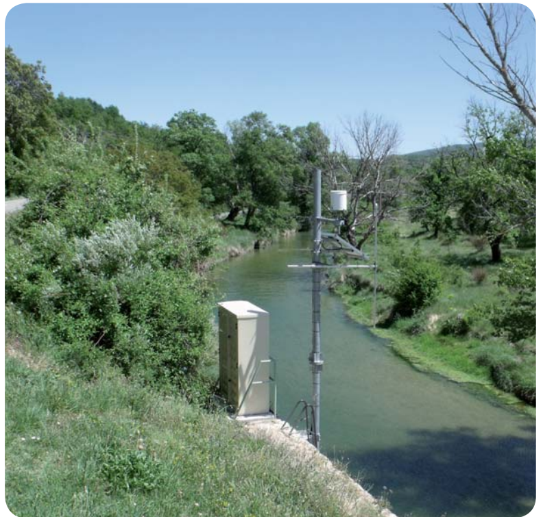
Échelle limnimétrique au seuil de Costeraste pour mesurer les hauteurs d'eau
