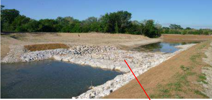
Recouplement du méandre : Seuil de calage
