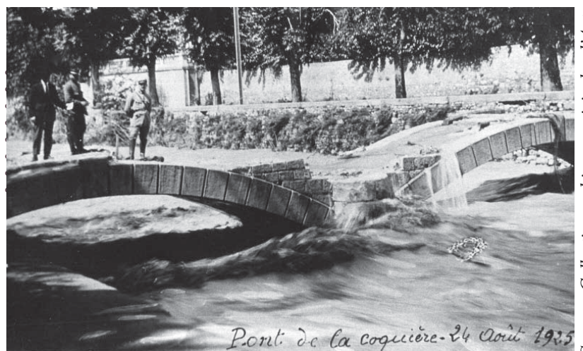
Le Pont de la Coquièrè à la décrue . Son tablier a disparu et l'eau défile encore avec violence.
