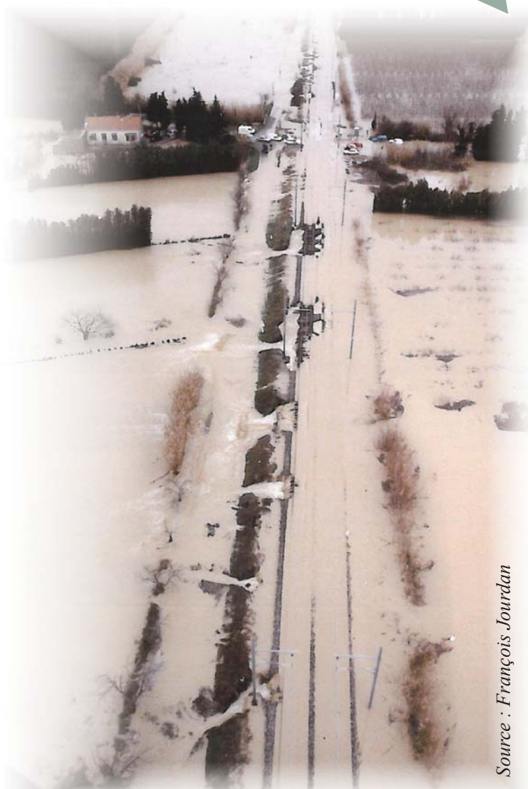
La voie ferrée lors de la crue de 1994.
